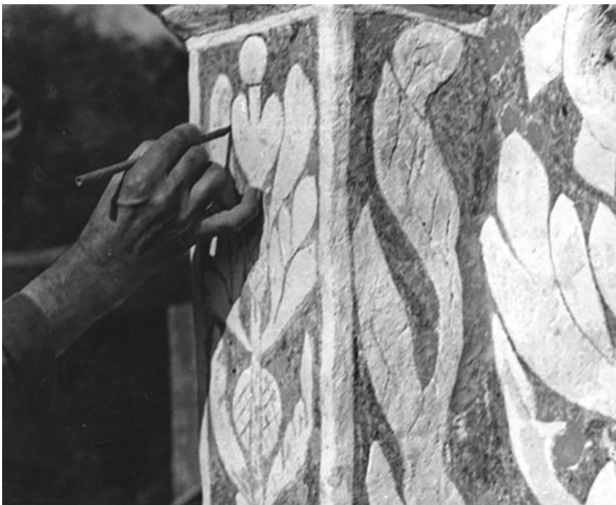
10. A pácini Mágóchy-kastély sgraffitóinak restaurálása, 1963. MÉM MDK, Tervtár, ltsz. D 25335. © Magyar Építészeti Múzeum és Műemlékvédelmi Dokumentációs Központ, Budapest
